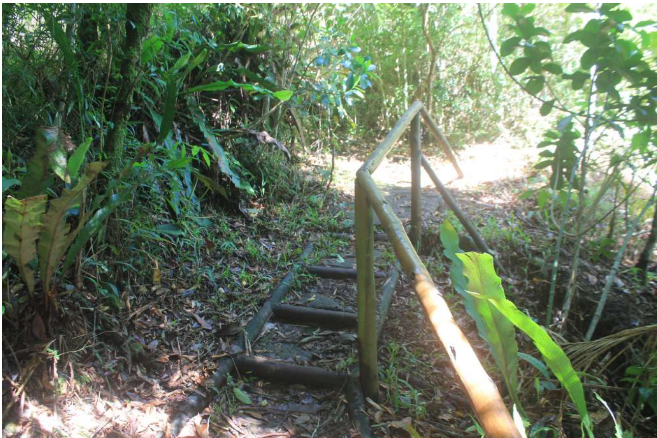
Figura 10. Exemplo da utilização de longarinas para minimizar os danos causados por erosão hídrica na trilha do Parque Estadual Forno Grande.
